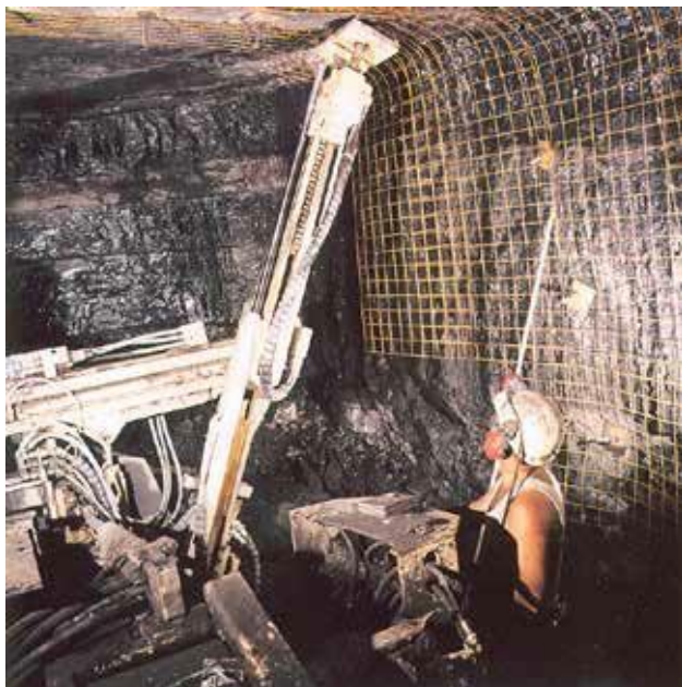
Abbildung 2: Betreiben der Sandvik-Verankerungsanlage, die an der Teilschnittmaschine tief im Untergrund befestigt ist.
